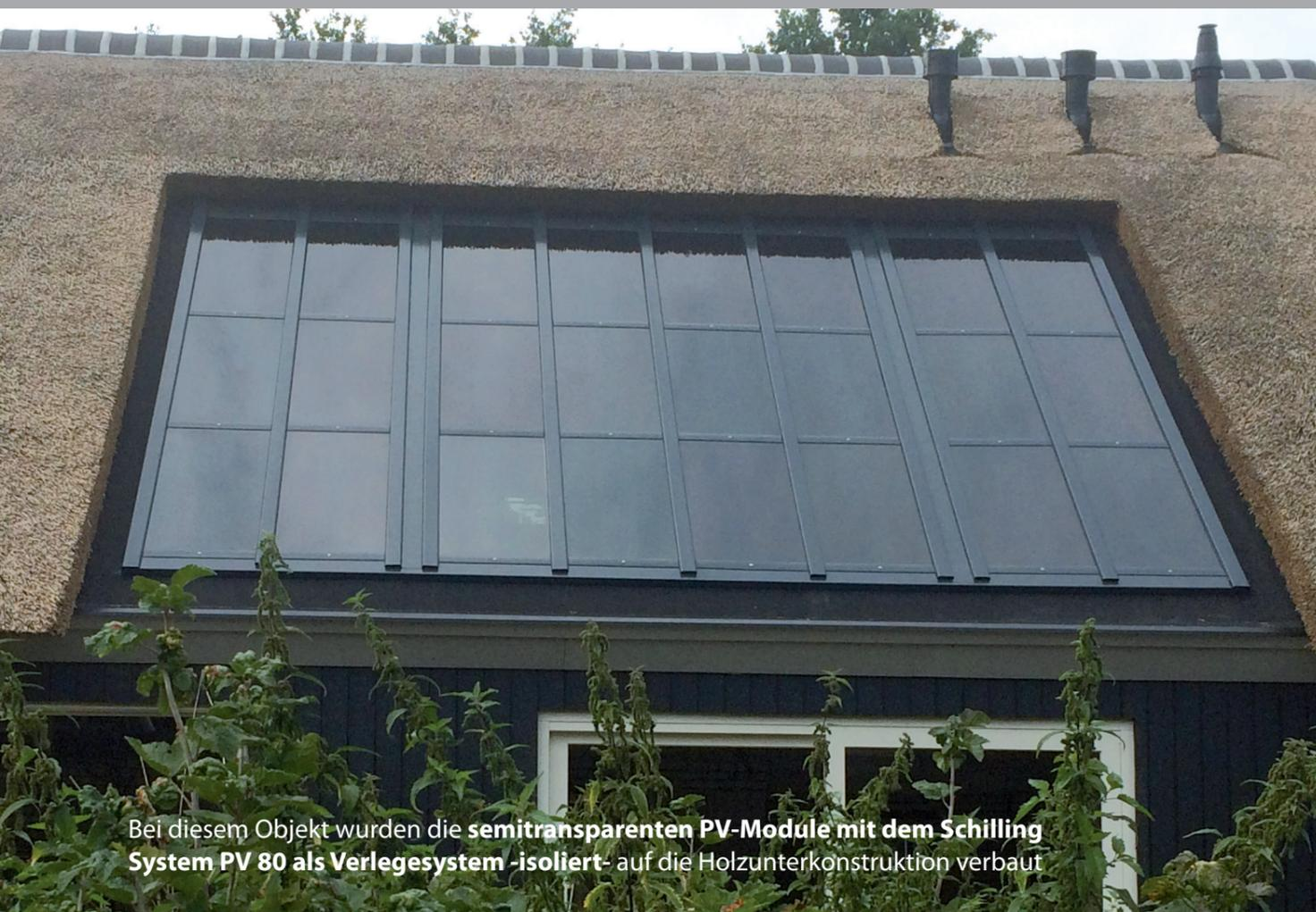
Bei diesem Objekt wurden die **semitransparenten PV-Module mit dem Schilling System PV 80 als Verlegesystem -isoliert-** auf die Holzunterkonstruktion verbaut
