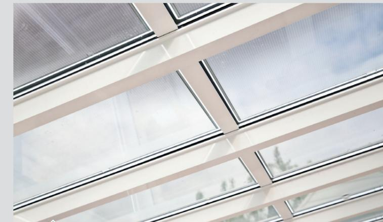
Semitransparente PV-Module montiert mit dem **PV 80 System -isoliert-**
